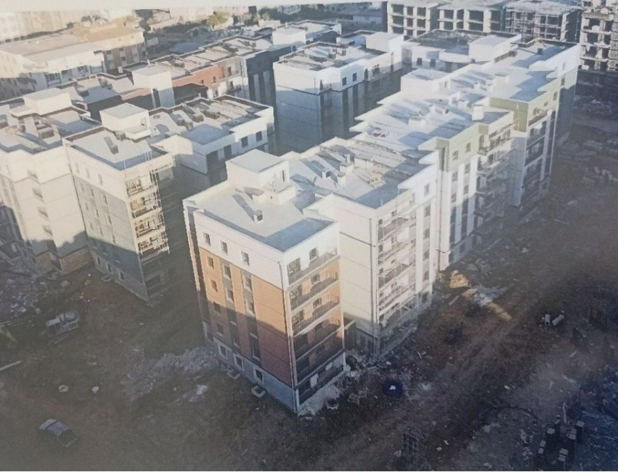
Antakya Saraycık projesi. Yapım aşamasından saha fotoğrafı.
